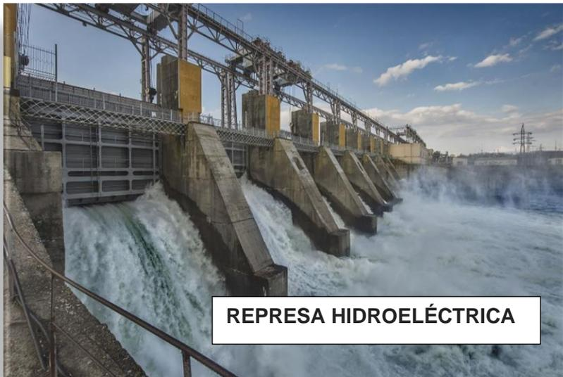
Las **represas hidroeléctricas** son sistemas diseñados y construidos para producir energía eléctrica mediante el aprovechamiento del caudal de los cursos de agua.
